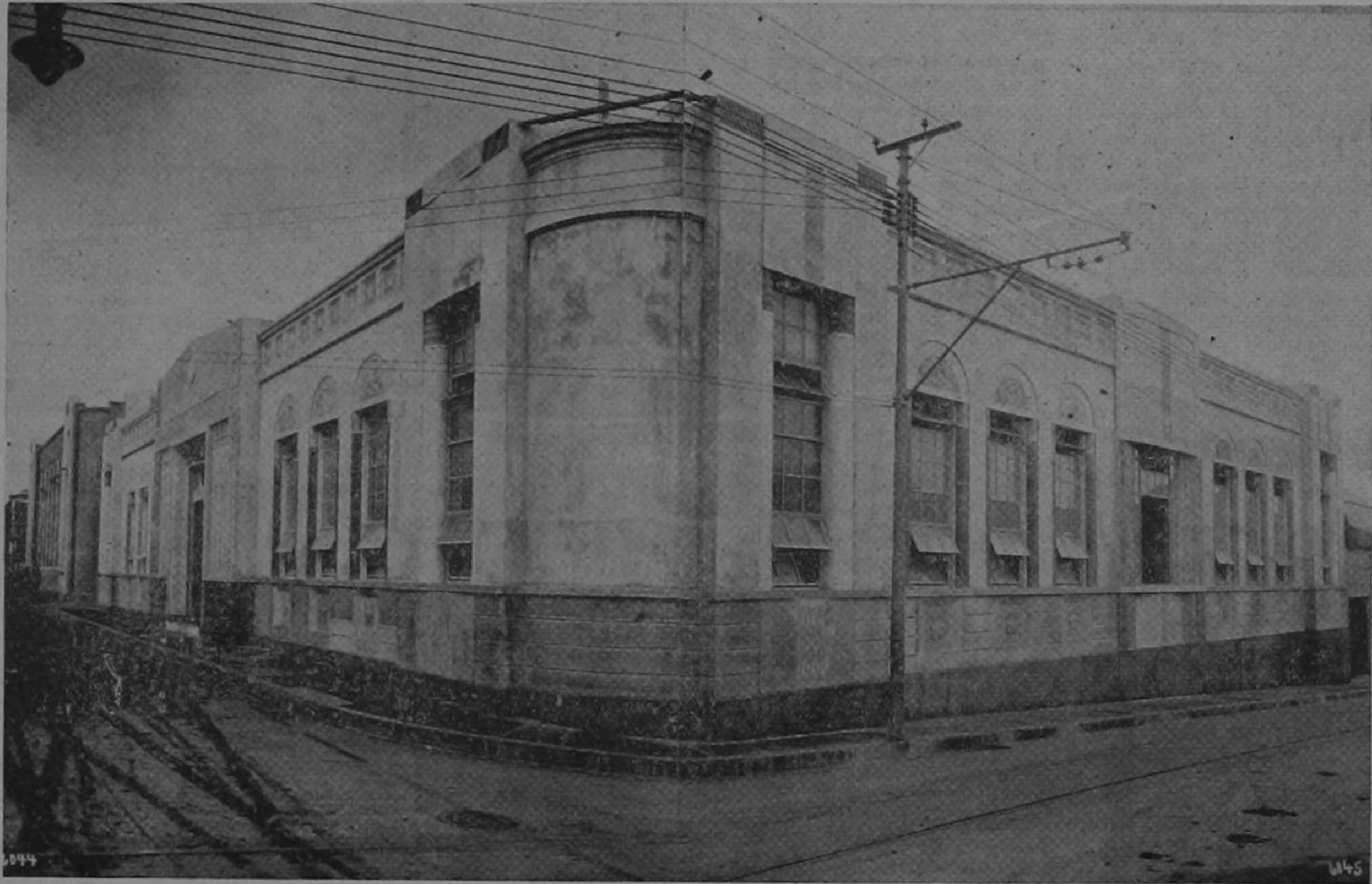
El nuevo edificio del Banco Nacional de Seguros, moderna construcción de cemento armado, situado en la esquina que forman la Avenida Fernández Guell y la Calle 10
