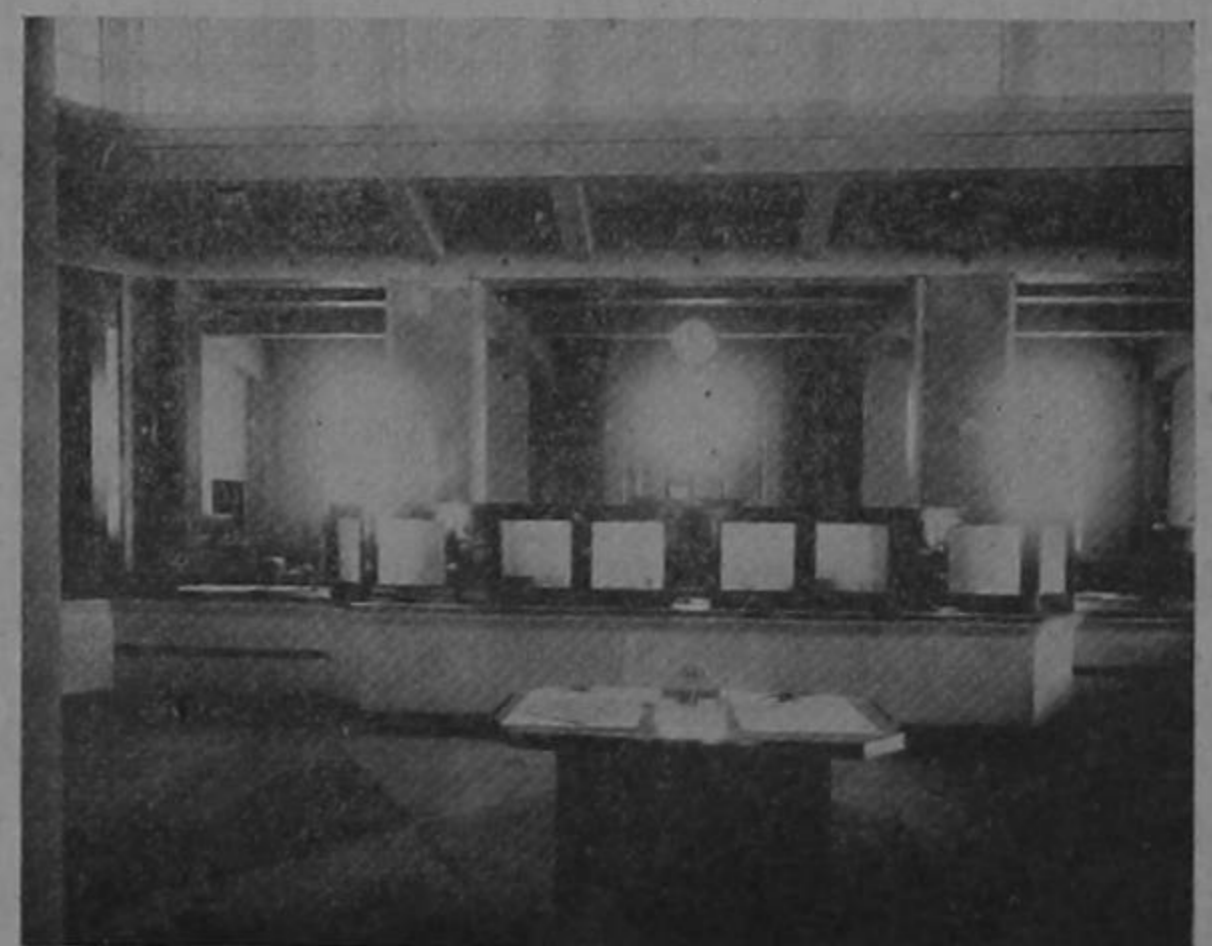
Despacho de los cajeros del Banco y vista parcial del salón del público
