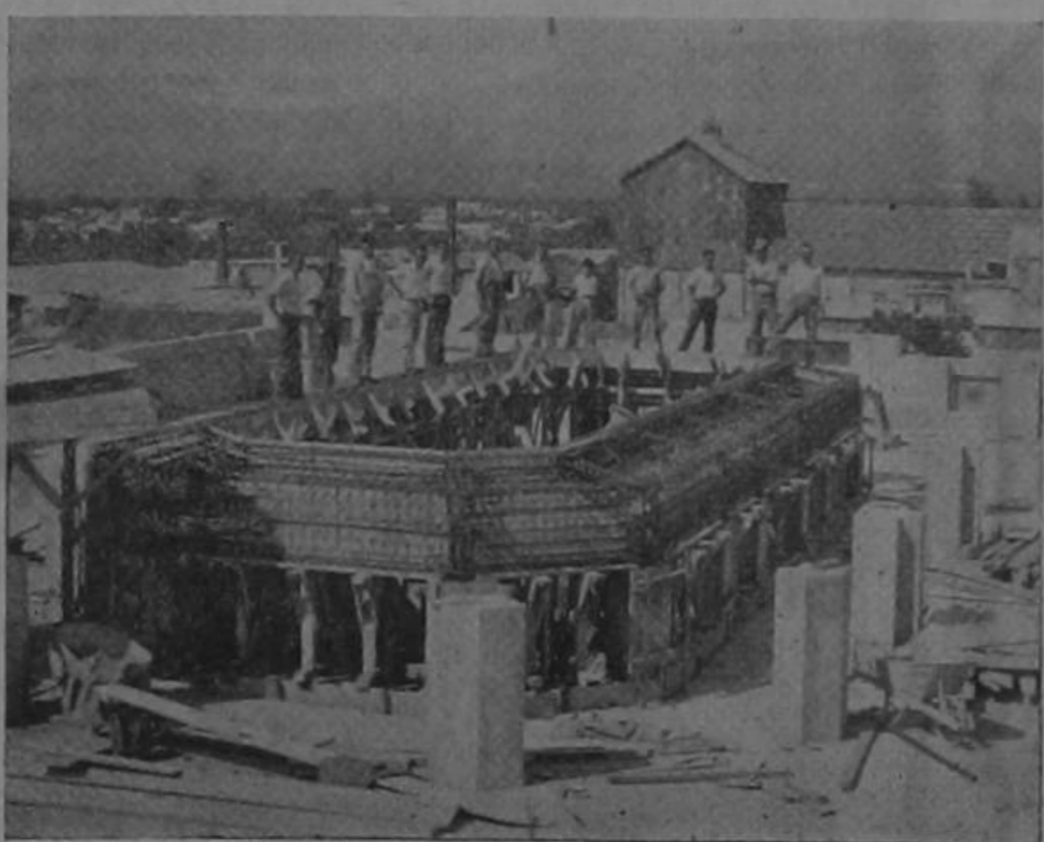
Armadura del Hall para el techo de vidrio-concreto
